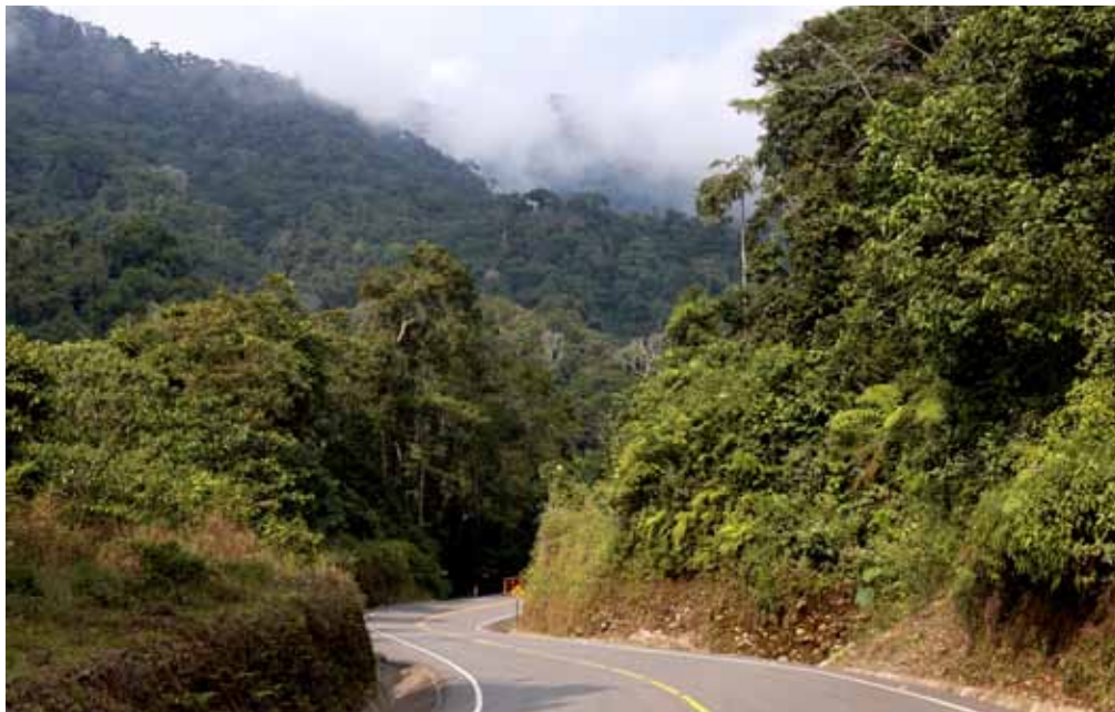
La carretera Interoceánica ha sido una demanda de décadas de los pobladores de la zona. Ahora, cuando ya es utilizable en la mayoría de sus tramos y está a punto de ser terminada, alrededor de 100 kilómetros literalmente se irían al agua.
